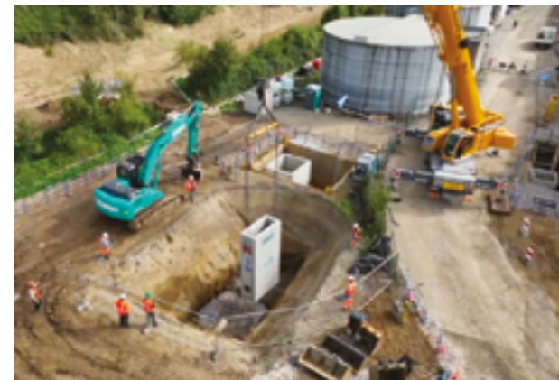
2,4 M€ investis sur le site de Gondardennes pour récupérer les eaux de pluie sur 11 hectares (2023-24).
