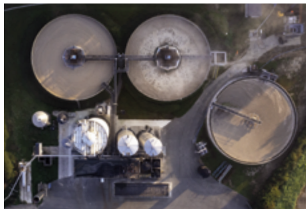
Station d'épuration de Cartonnerie Gondardennes
